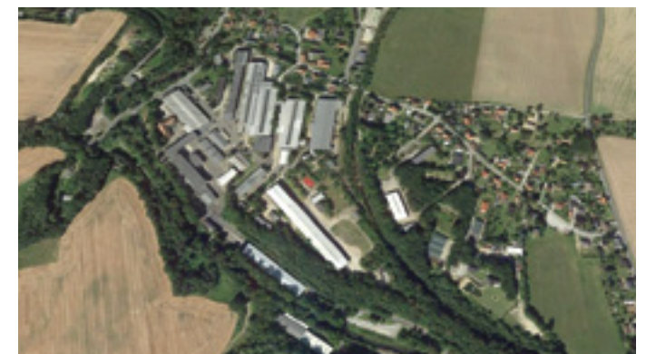
Abb. 3.4: PV-Anlage ehemaliges Gewerbegebiet MDW [4], Quelle: © Google Earth
