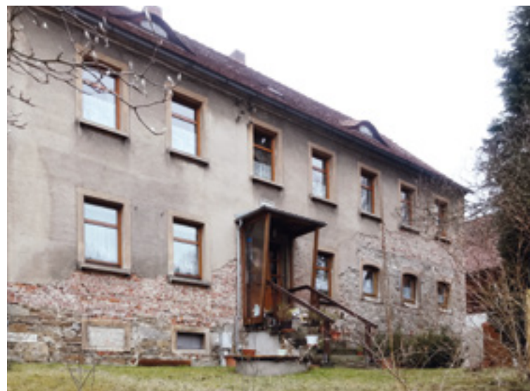
Abb. 3.6: Wohngebäude in Obergurig nach WschVO 1977
