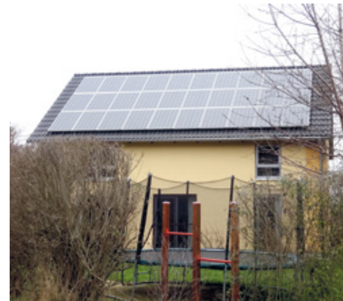
Abb. 5.6: Photovoltaikanlage auf einem Einfamilienhaus in Obergurig
